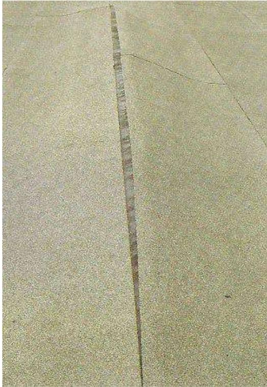
Membrana impermeabilizzante sotto la pressione del coibente in poliuretano
