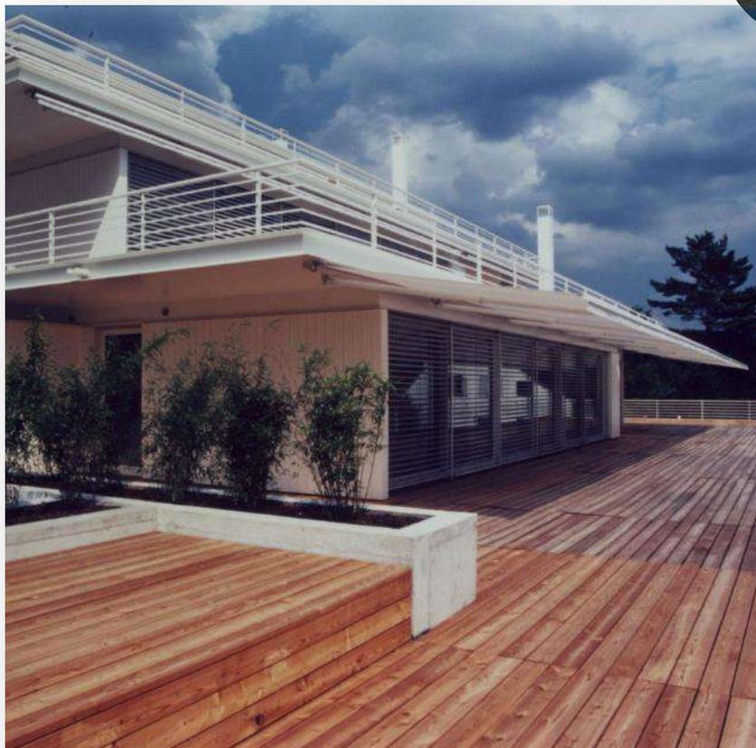
**Terrazzi con deck in legno su sottostruttura metallica e pavimentazione in pietra su ghiaietto**
